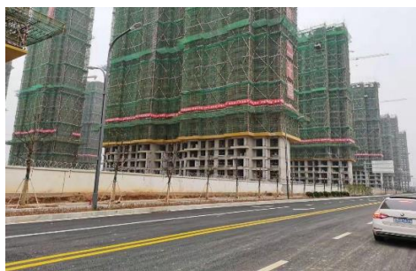
图 2.3 在建的梦庐居住小区
