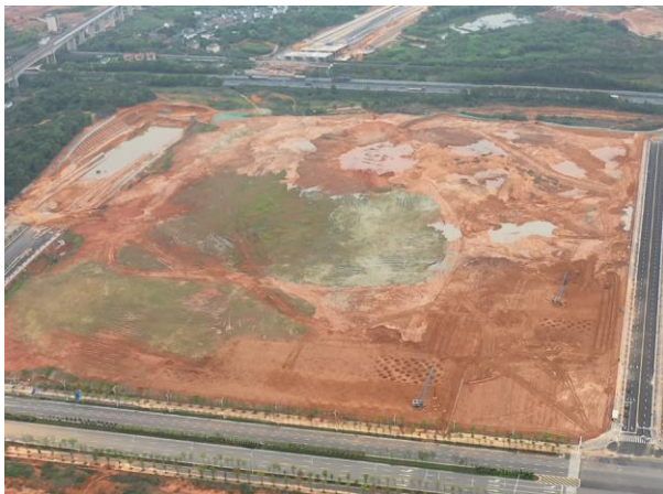
在建汽车产业园项目
