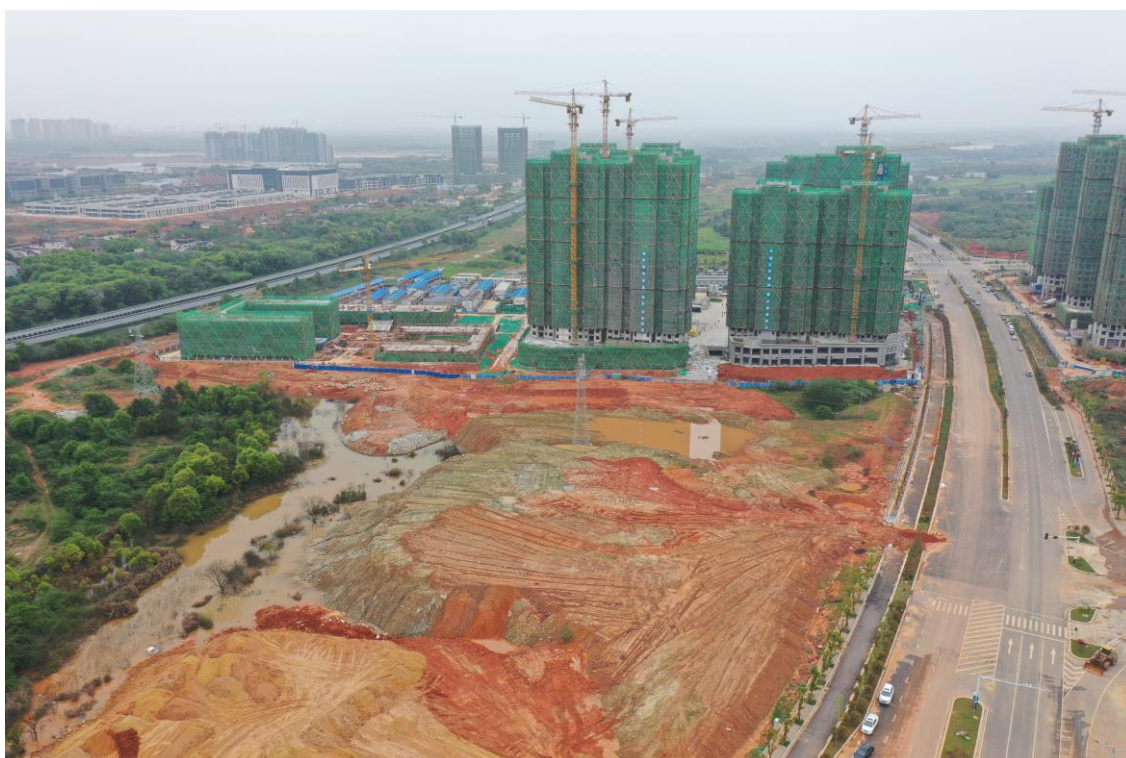
图 2-25 望城新区规划的安置房项目回填现状
